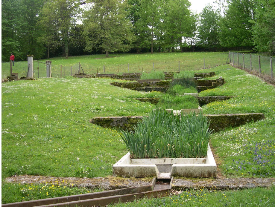
Fig. 4 : Seconde installation de phytoépuration, désormais séparée du foyer éducatif 4
