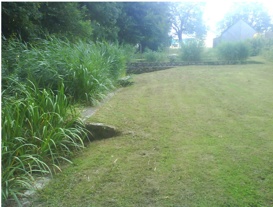
Fig. 3 : Première installation de phytoépuration au Logis 2
